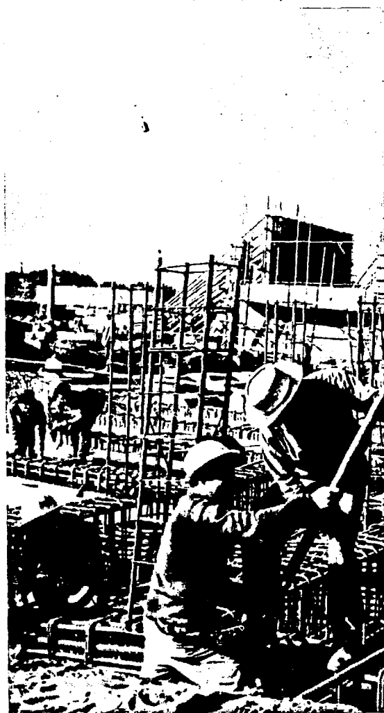
Planta de Cloro-Soda de Petroquímica Chilena, en construcción (Concepción).
