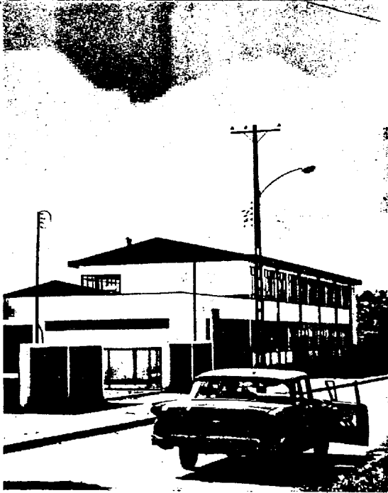
Escuela Industrial y Básica en Valdivia (Valdivia).
