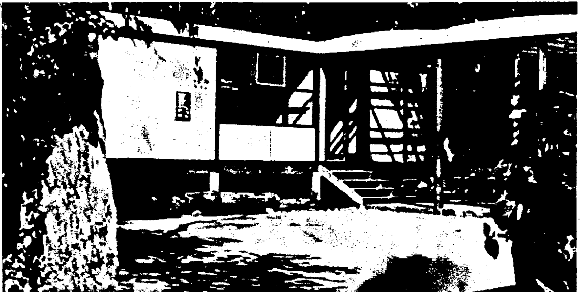
Edificio de servicios para la comunidad en comuna La Reina (Santiago).
