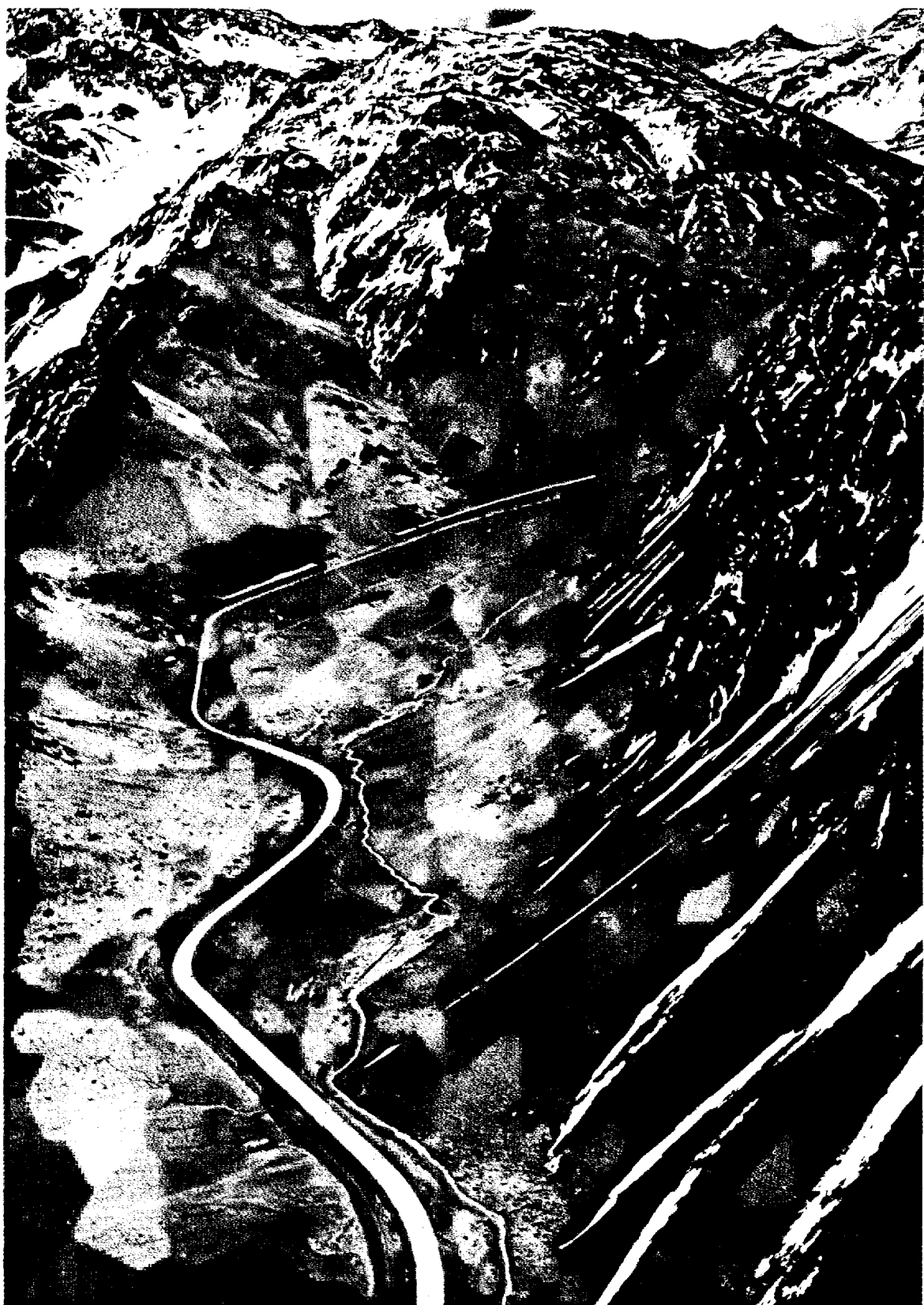
Camino de Valparaiso a Mendoza (Argentina), en construcción.
