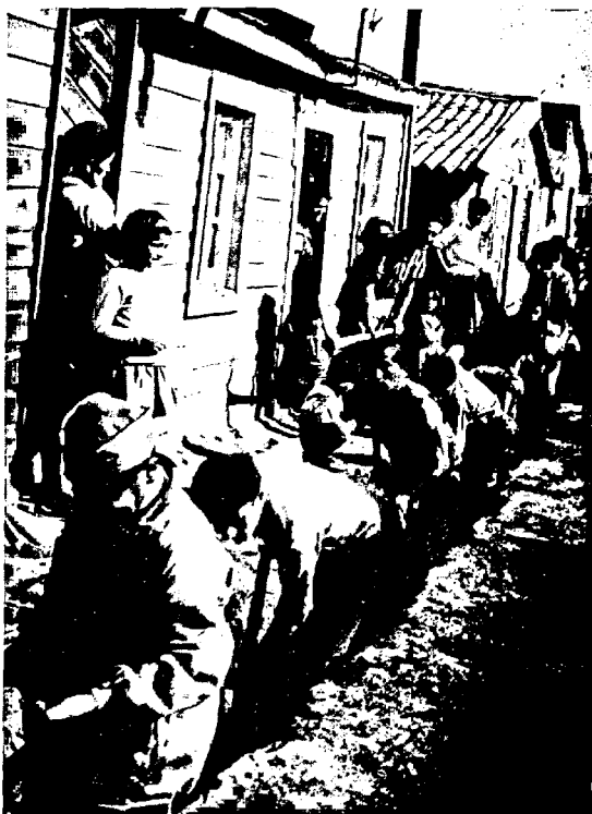
Autoconstrucción en Cautín. Instalación de agua potable.
