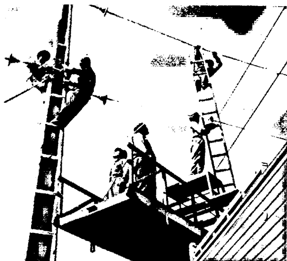
Electrificación de Ferrocarriles (tramo de Talca).
