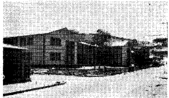
Hospital de Vallenar.
