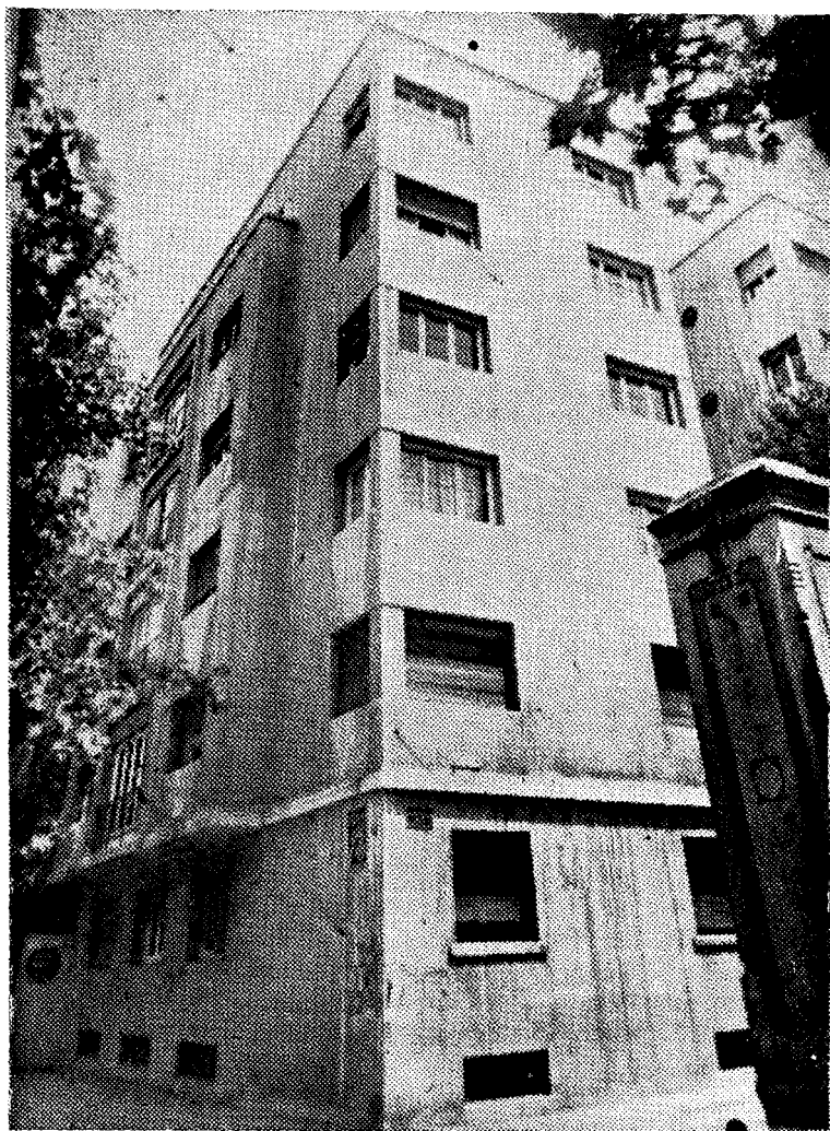
EDIFICIO VICUÑA MACKENNA N.º 115. — 6 pisos, 24 departamentos terraza y subterráneo.
