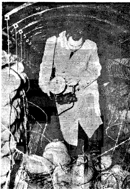
Un túnel que permitía interceptar todas las llamadas telefónicas del país.
