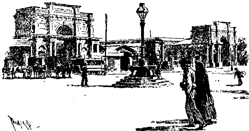
La Estación Central
