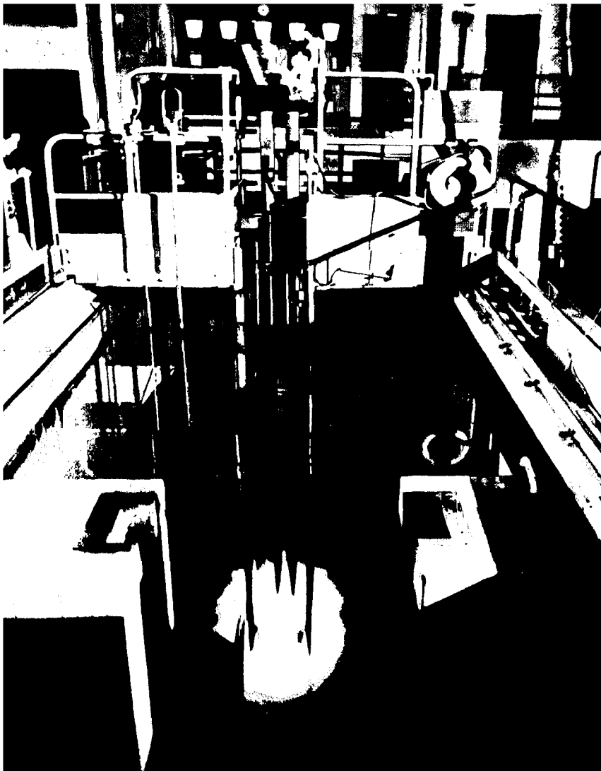
Fotografía 1. Reactor de investigación tipo "piscina". El brillo emitido por el núcleo del reactor en el fondo de la piscina se llama "Radiación Cherenkov" y ocurre cuando partículas cargadas de electricidad pasan a través de un medio transparente a velocidades superiores a la velocidad de la luz.
