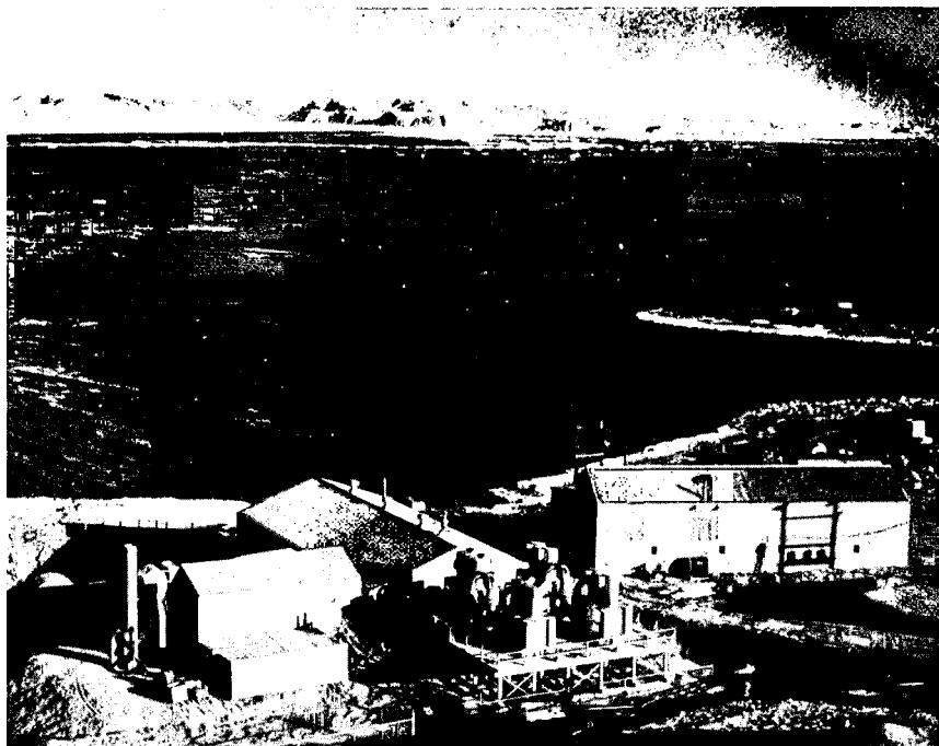
Fotografías 5A y 5B — La planta de energía atómica portátil PM-3A. En la fotografía superior aparece una sección de la planta en los momentos de descargarse en McMurdo Sound, Antártica. Fotografía inferior — Vista panorámica de la instalación completa.
